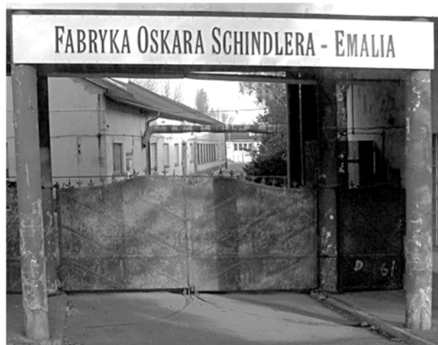
Usine de Schindler
